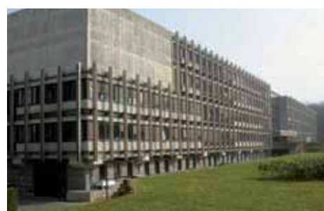
▲ The actual CODA-CERVA building (1992)
